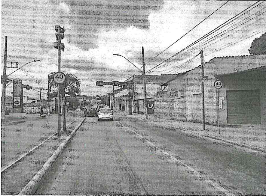
Vista do local fiscalizado.
