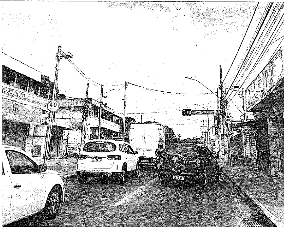
Vista do local fiscalizado.
