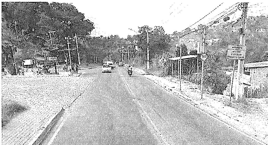
Vista do local Fiscalizado
