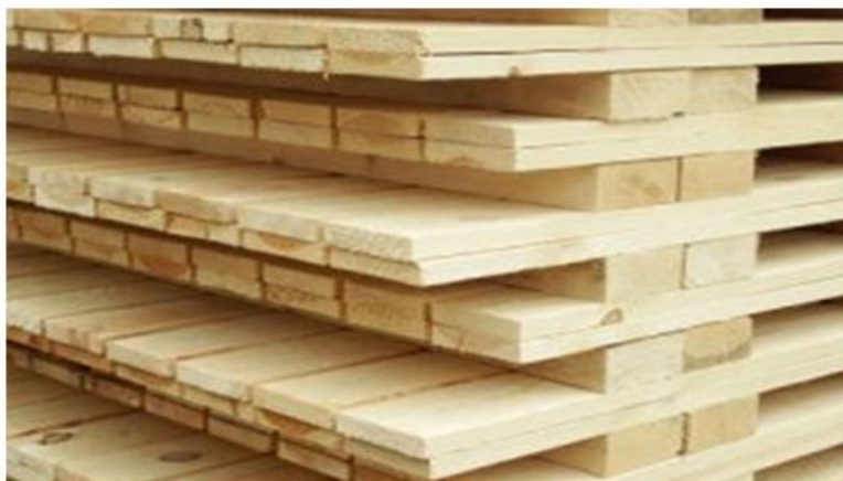
Figura 3 - Armazenamento das fôrmas
