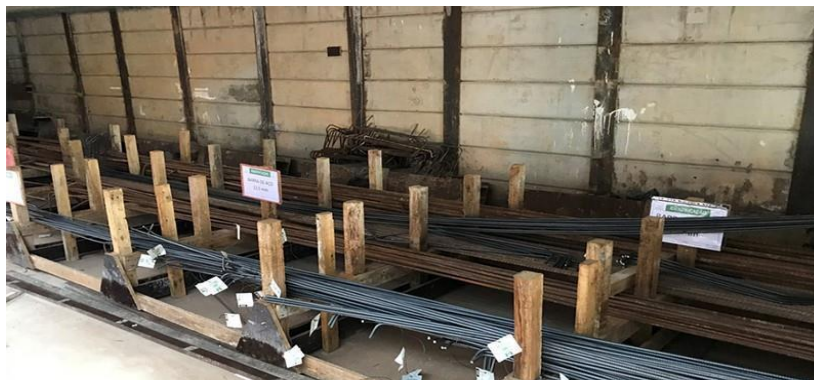
Figura 2 - Armazenamento das armaduras
